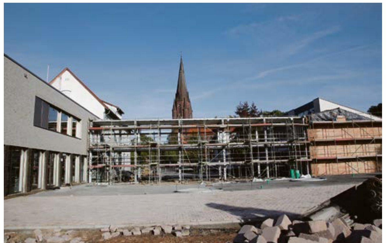
Mit einem Glasgang wird in den nächsten Wochen der Umbau der Wieschhof-Grundschule weitgehend abgeschlossen.
