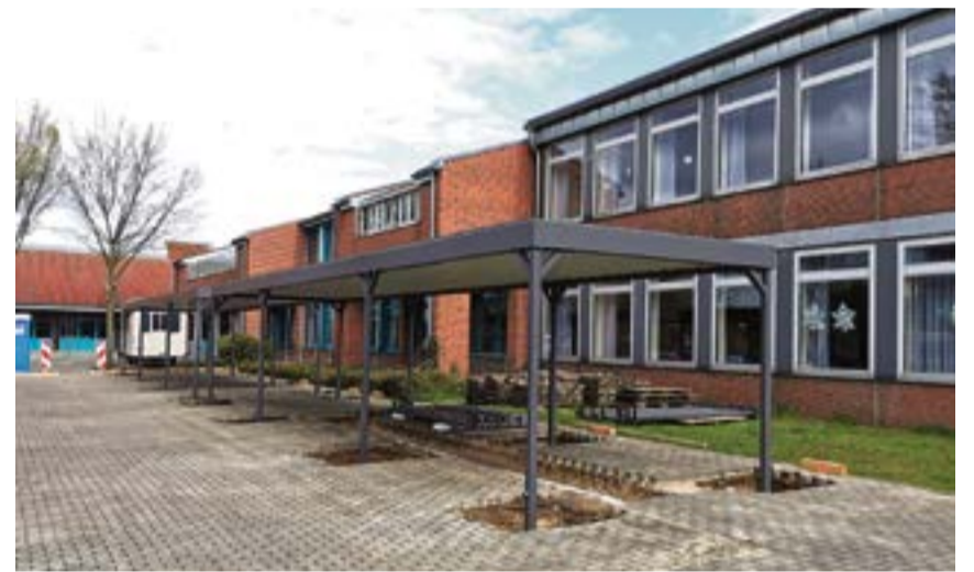
Die Fahrradabstellanlagen an den beiden Olfener Schulen sind im Bau.
