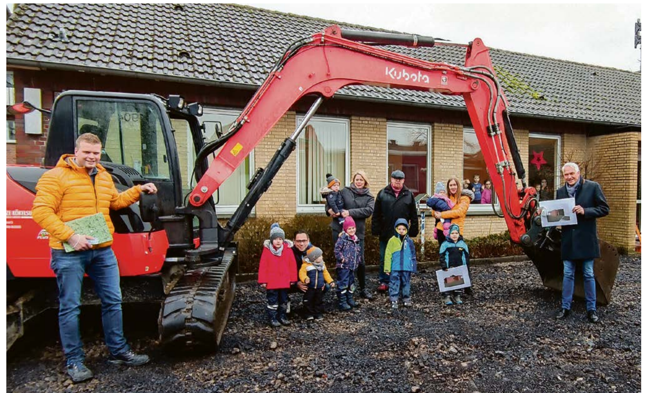
Die Stadt Olfen, die Verantwortlichen des Kindergartens Arche Noah und vor allem die Kinder freuen sich über den Baubeginn.
