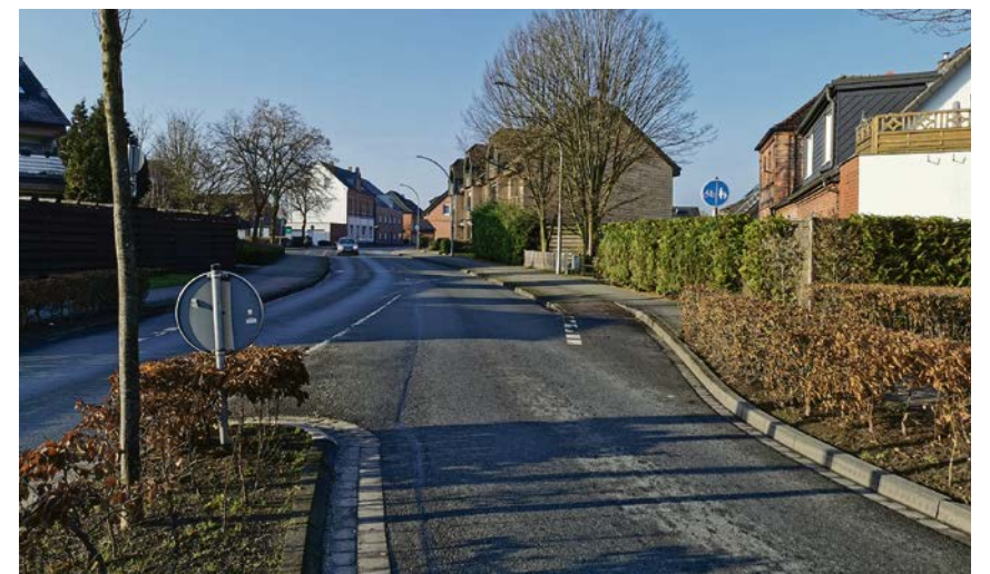
Zwischen den Kreisverkehren Rewe und K&K soll die Straße umgebaut werden.
