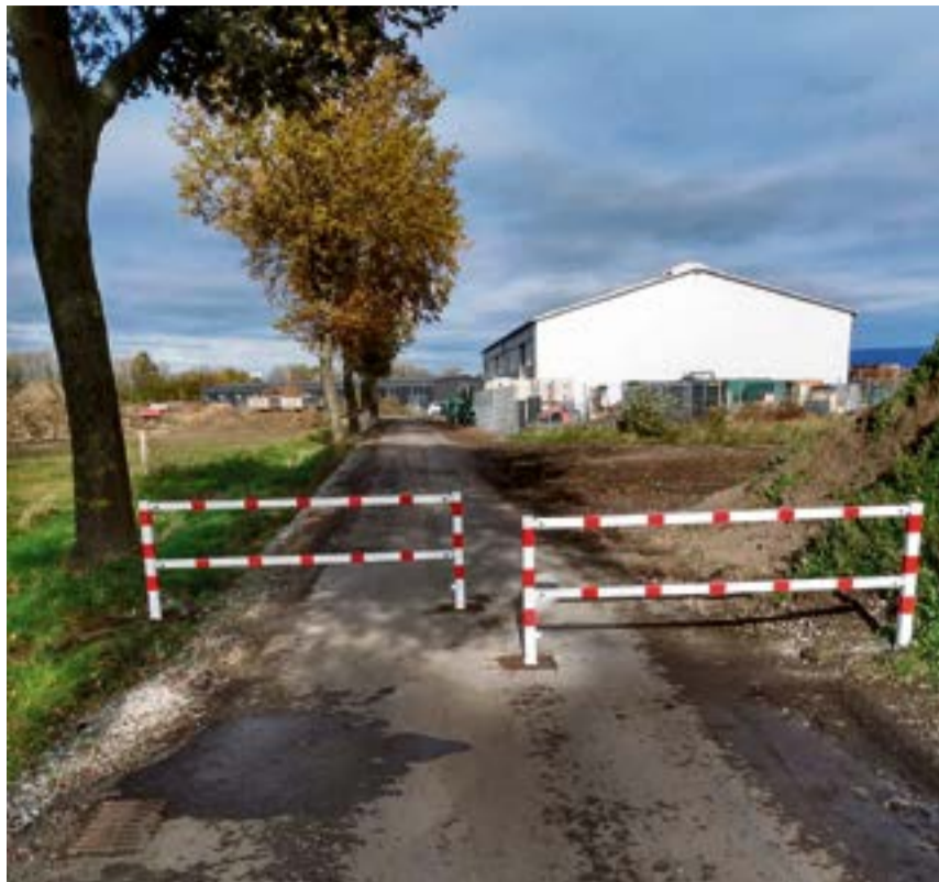
Die Wirtschaftswege Markenweg und Hahnenberg wurden dauerhaft gesperrt.
