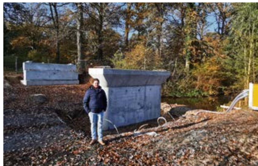
Niklas Zuz zeigt den Baufortschritt an der neuen Radbrücke.
