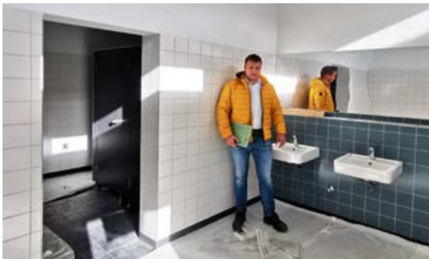
Die Sanitäranlagen am Schulhof der Gesamtschule wurden komplett saniert.
