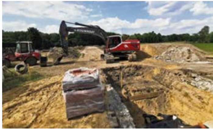
Die Erschließungsarbeiten im Baugebiet Lüdinghauser Straße haben begonnen. Für das neue Baugebiet „Olfener Heide“ werden derzeit alle Weichen für die Vermarktung gestellt.
