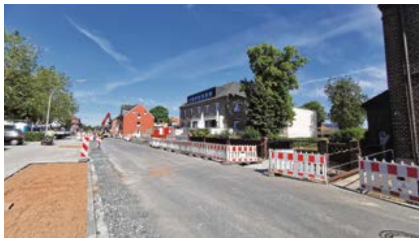
Die Bauarbeiten an der Bilholtstraße sollen bis zum Herbst abgeschlossen sein.
