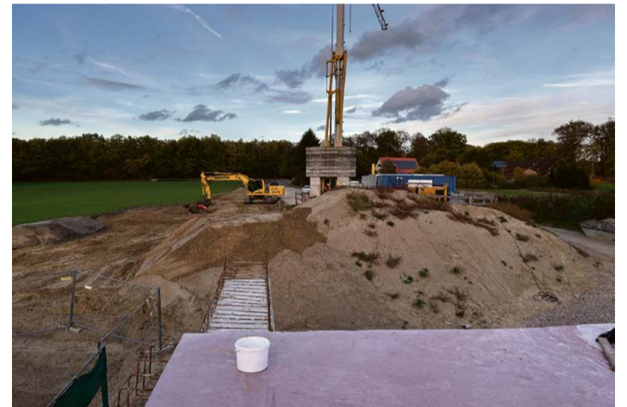
Die Arbeiten an der Ahsener Brücke sind weit fortgeschritten. Jetzt wurde Richtfest gefeiert.
