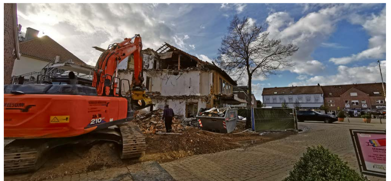
Die Abrissarbeiten neben dem Rathaus sind abgeschlossen. Zeitnah kann mit dem Bau des neuen Rathauses begonnen werden.
