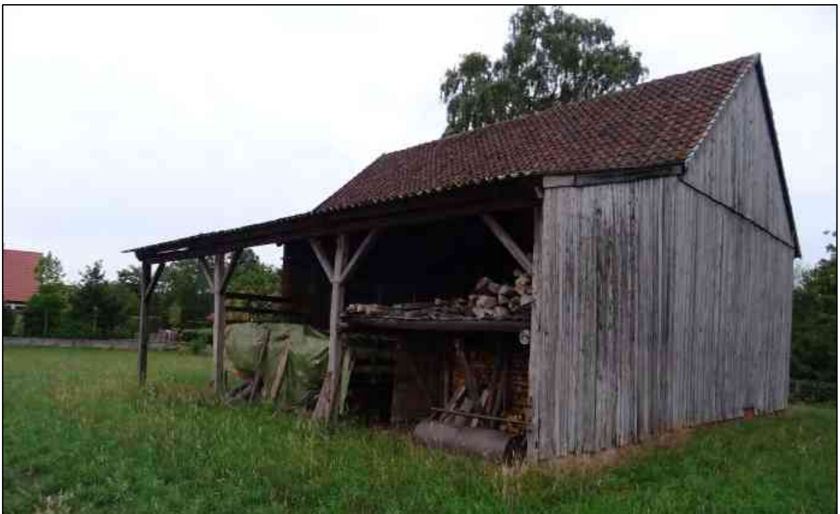
Abbildung 9: Scheune im Südosten des Plangebiets (Blickrichtung Süden).
